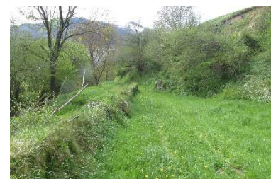
Aperçu du muret à conserver
